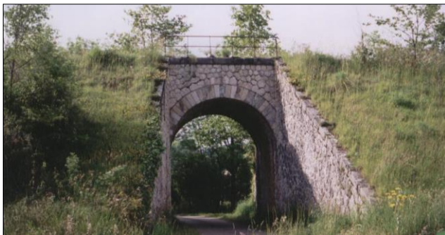
Pont en maçonnerie sous la voie communale n°5 menant au monastère de Carol – 2003
