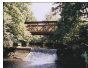
Pont en structure métallique sur l'Arize
