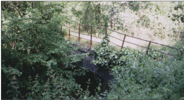
Pont en maçonnerie au dessous d'un chemin communal - 2003
