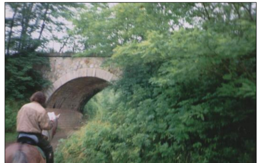
Pont en maçonnerie sur le chemin de Fontanel ( 2003)
